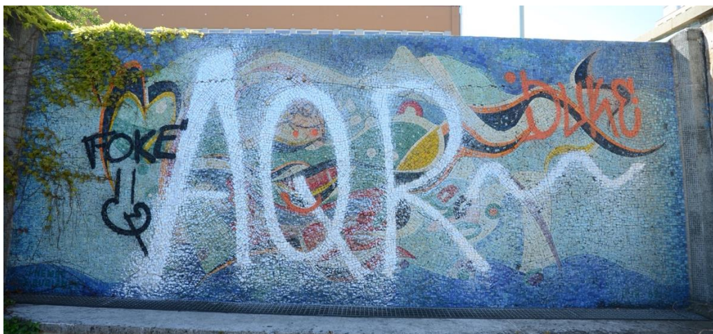
Obr. 7 Pohled na mozaiku „Duha“ před čištěním.
