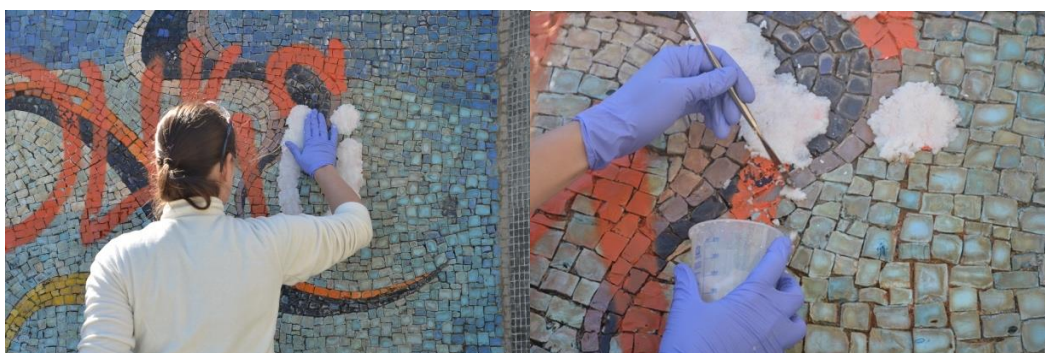
Obr. 8 a, b: Odstraňování graffiti mikroemulzním systémem. a) Nanášení zahuštěného mikroemulzního systému na povrch graffiti. b) Snímání obkladu.
